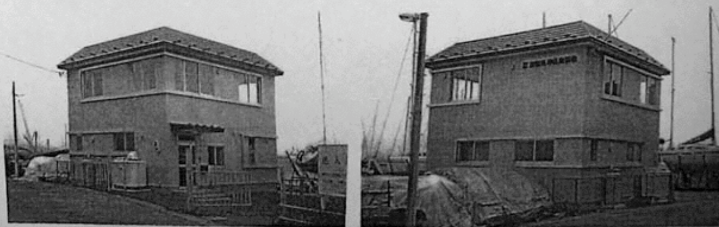
マリンVHF海岸局舎完成写真
